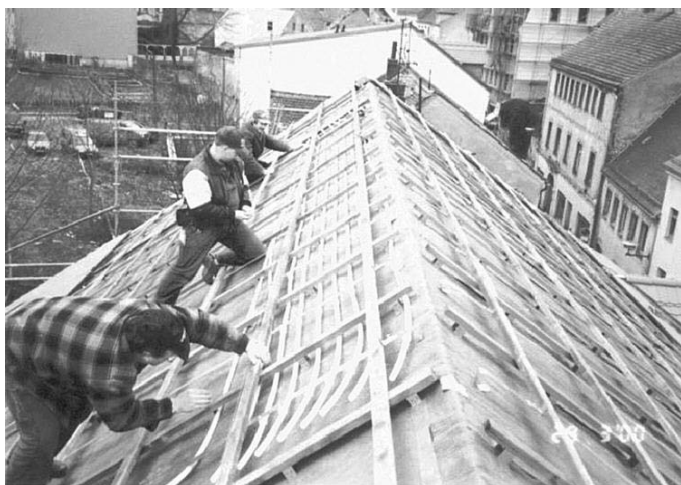
Bild 2: Montage des Schlauchabsorbers unter die Dachlattung eines Gebäudes im mittelalterlichen Stadtkern von Zittau
